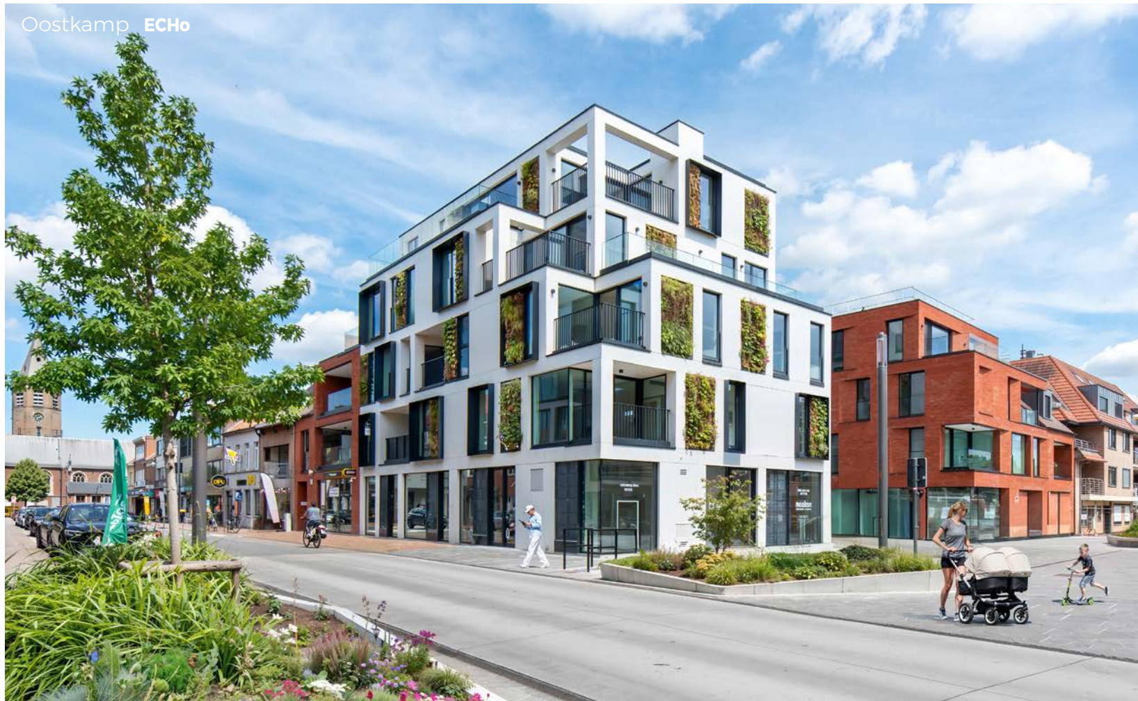
De twee complementaire bouwdelen creëren samen een verticaliserend geheel met een compacte footprint.
