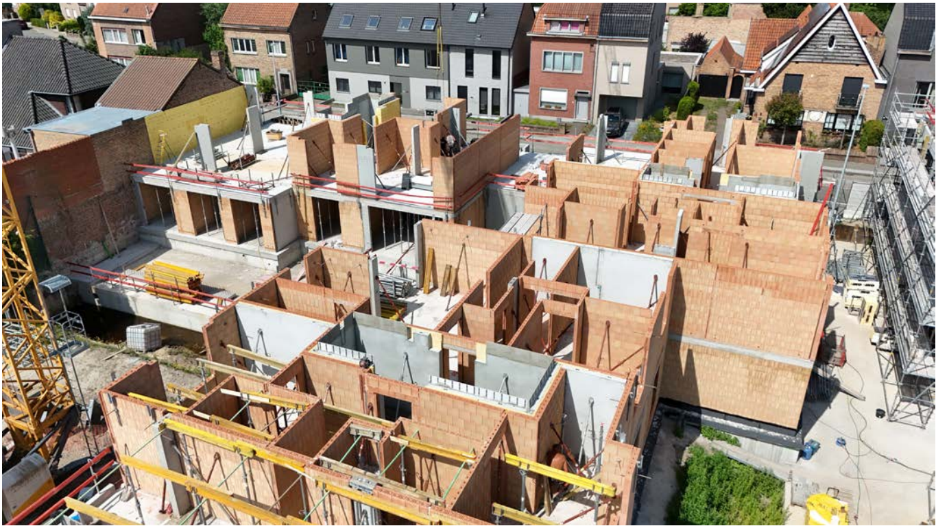
De ruwbouwfase ging van start in februari, met als streefdoel: wind- en waterdicht in september, volledige afronding van de ruwbouw tegen midden oktober.
