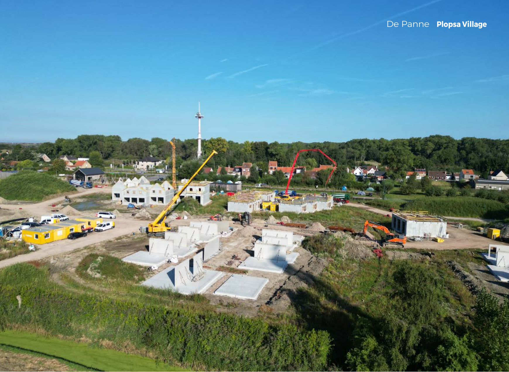
De woningen arriveerden in grote modules op de werf, inclusief dakstructuur.
