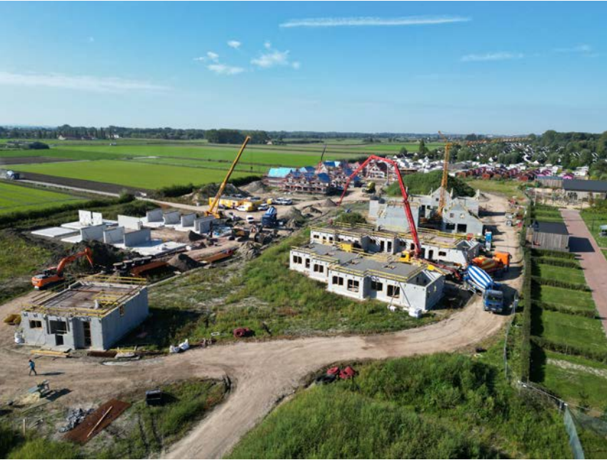
De prefabmodules die op de werf toekwamen, werden ter plaatse monolithisch aan elkaar gekoppeld.
